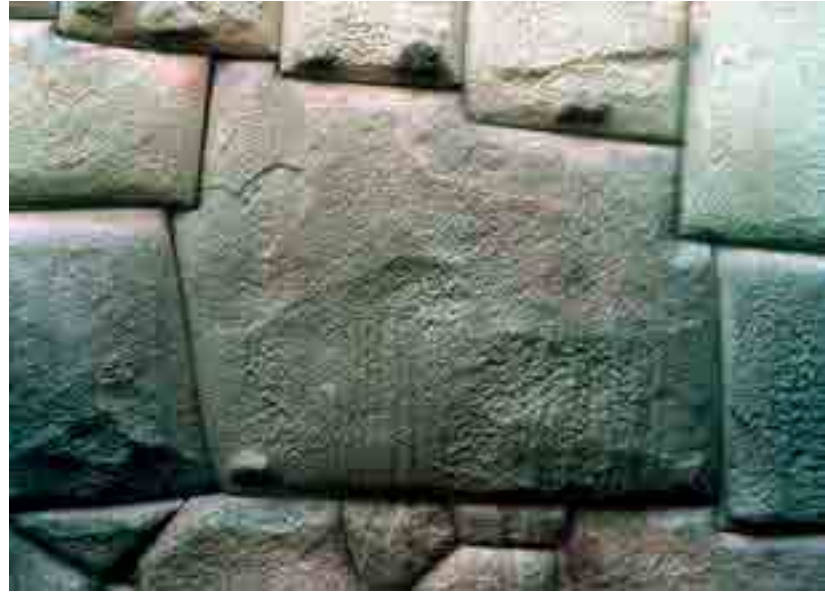
Die Mauer des Palastes des Inca Roca hat nach 800 Jahren noch zum größten Teil seine Struktur erhalten aufgrund der Anordnung der Natursteine auch ohne jegliche Bindemittel.
